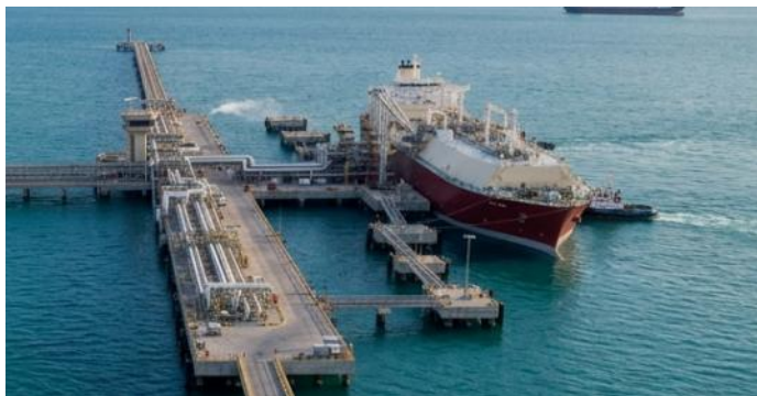
LNG EXPORT TERMINAL
